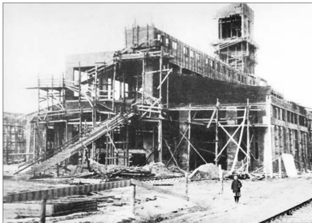
Июль 1930 года. Строительство первого цеха
