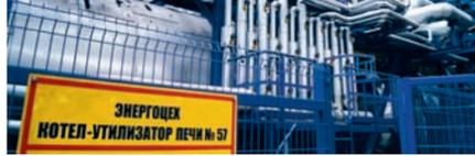
Этот котел конструктивно отличается от котлов-утилизаторов печей цеха. Он жаротрубный, т.е. дымовые газы от печи проходят по множеству труб внутри котла, нагревая воду, которая омывает эти трубы. Котлы цеха известны водотрубные, т.е. там, наоборот, дымовые газы нагревают трубы, по которым циркулирует вода.
