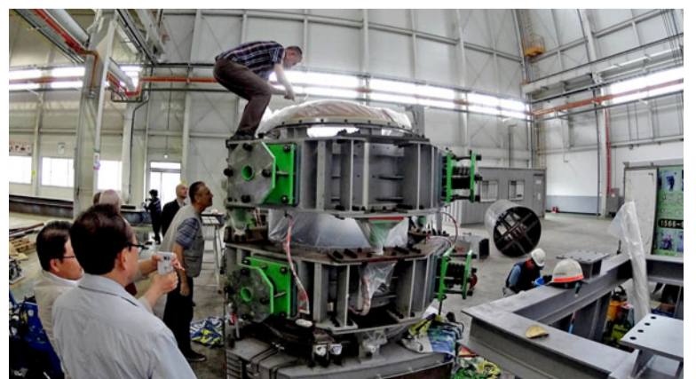
В производственном цеху компании SAC. Осмотр механизма перепуска электрода
