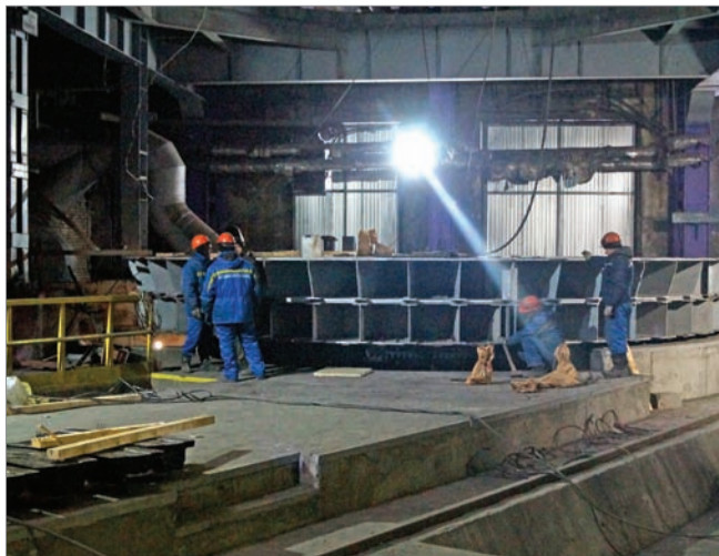
Печь № 42. Идет монтаж механизма вращения ванны
