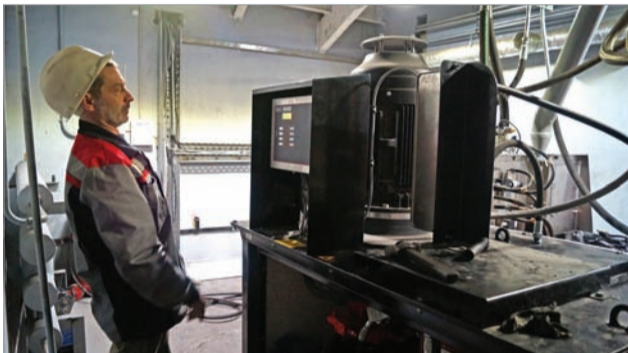
Владимир Линник в помещении гидростанции
