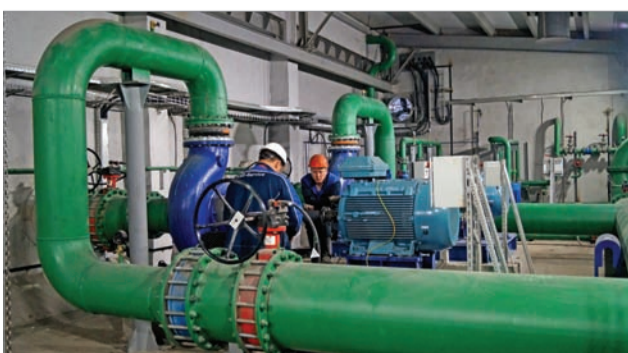
Отладка насосов холодного колодца
