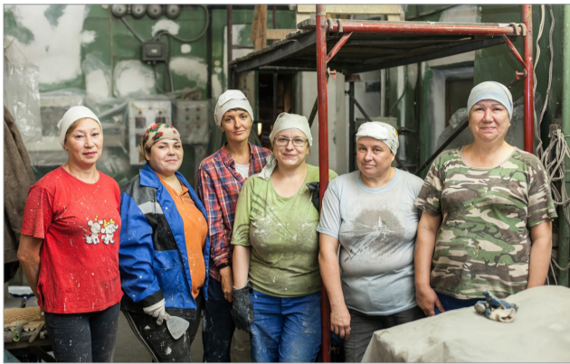
Бригада штукатуриков-маляров на ремонте пульты 21–22-й печей
