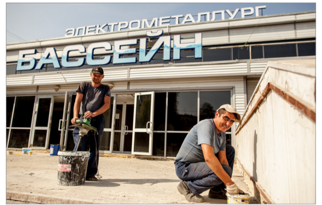
Бригада бетонщиков на ремонте крыльца бассейна «Электрометаллург»
