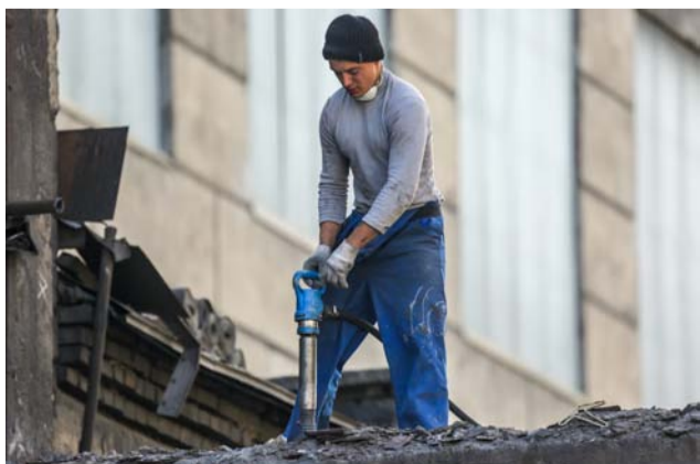
Демонтаж старых конструкций разливочной машины № 4
