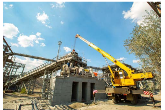
Ремонтные работы на новом участке
