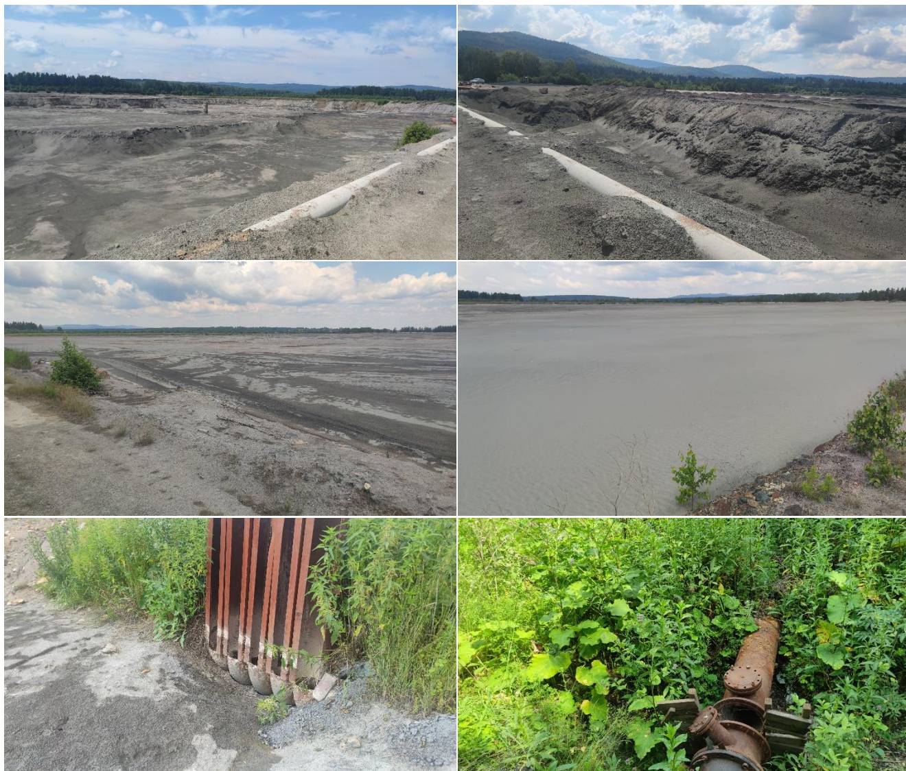
Рисунок 4.1. Общий вид гидротехнических сооружений хвостохранилища 2-й очереди Златоустовского агломерационного цеха акционерного общества «Челябинский электрометаллургический комбинат»
